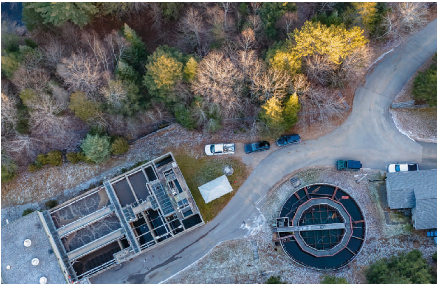
Luftbild der Wasser-Aufbereitungsanlage in Dysart (Ontario).
